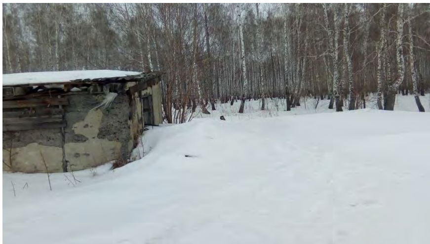
Надкаптажное помещение недействующей скважины.
