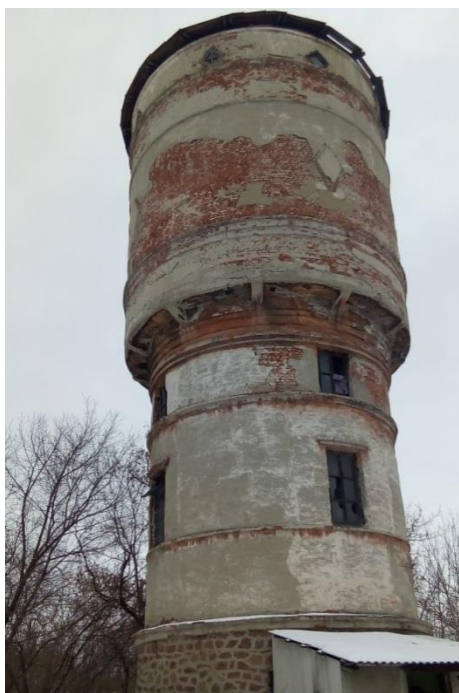
Действующая водонапорная башня возле ж/д станции
