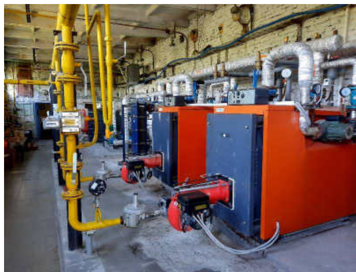
Оборудование котельной.
