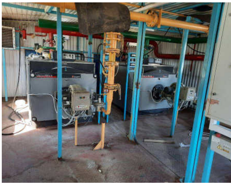
Оборудование котельной.
