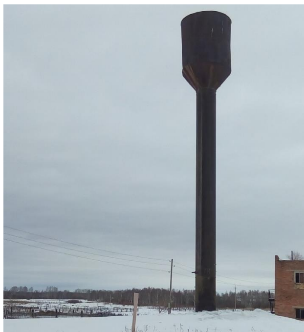
Водонапорная башня «Котельная».
